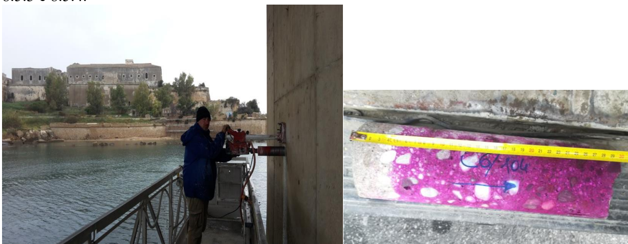
Figura 2a-2b – Prelievo di calcestruzzo mediante carotaggio e profilo di carbonatazione
