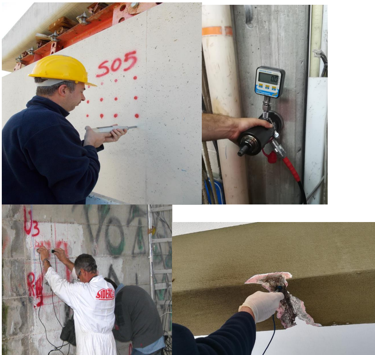
Figura 3a, 3b, 3c, 3d – Controlli non distruttivi sul calcestruzzo armato in opera, Sclerometro, Pull-out, Ultrasuoni e Durezza di barre di armatura
