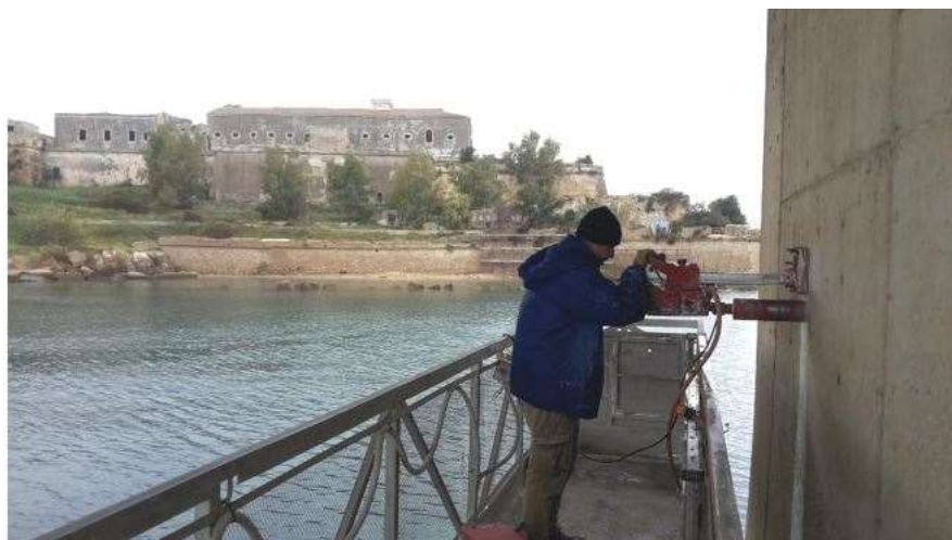
Foto 2 – Il carotaggio, (foto concessa da Sidercem s.r.l. Istituto di Ricerca e Sperimentazione)
