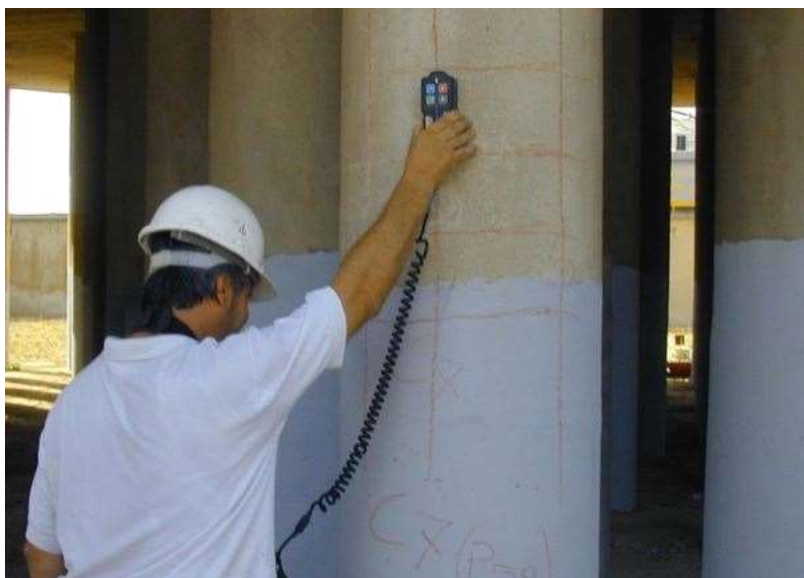
Foto 3 – Ricerca e tracciamento dell'armatura. (foto concessa da Sidercem s.r.l. Istituto di Ricerca e Sperimentazione)
