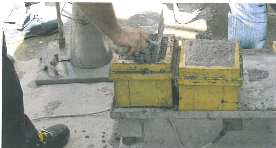
Fig. 11 Costipamento dei provini di calcestruzzo.
