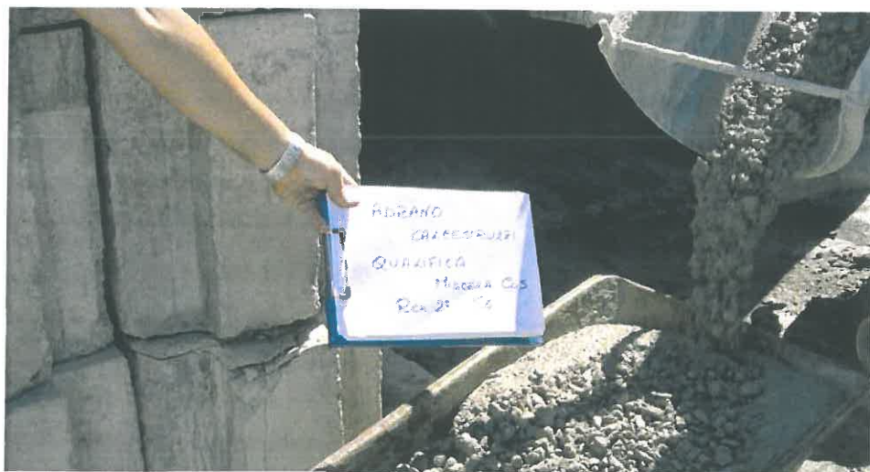
Fig. 2 Prelievo calcestruzzo, con carriola.
