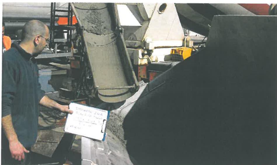
Fig. 9 Identificazione della autobetoniera.
