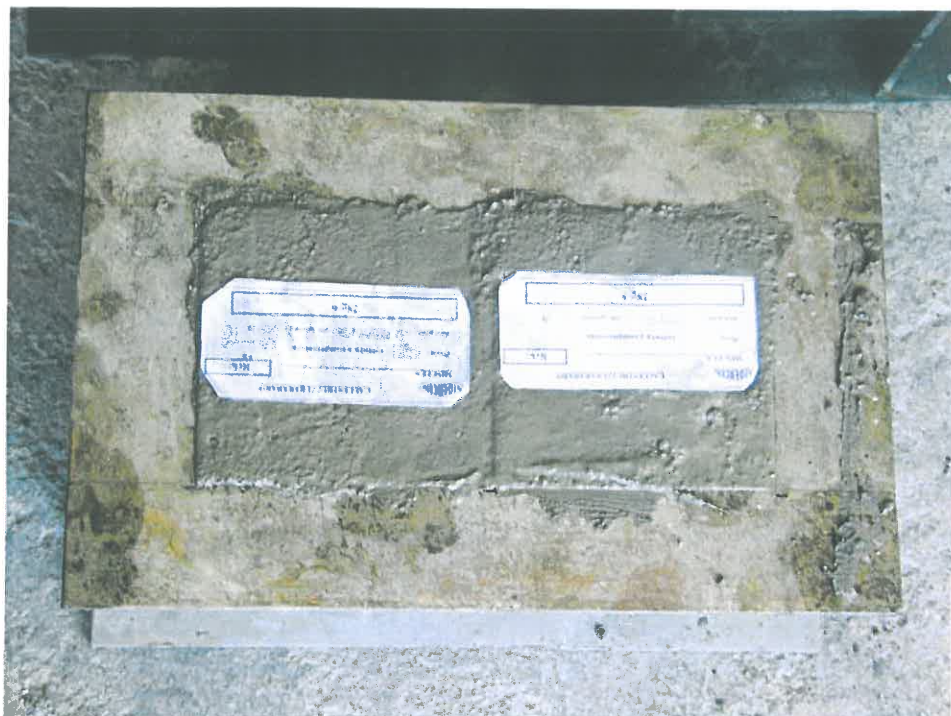
Fig. 12 Prelievo di due provini di calcestruzzo.
