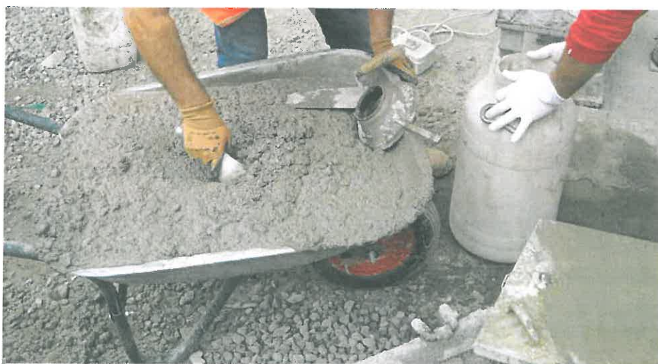
Fig. 10 Omogeneizzazione del prelievo di calcestruzzo.
