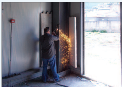
3A e 3B. Particolari del prelievo di carpenteria metallica
