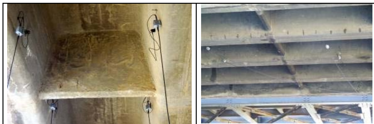
Figura 179 – Posizionamento dei sensori sulle travi.
