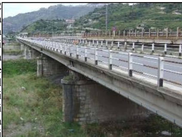
Figura 1 - Vista generale del viadotto.
