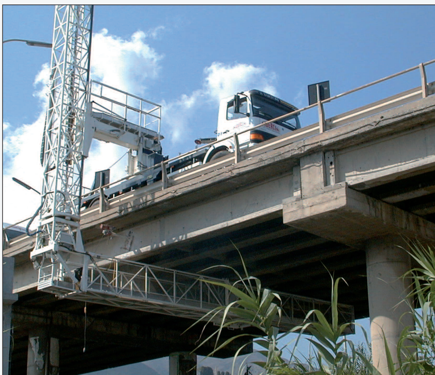
Figura 1 - L'ispezione sottoponte per la valutazione e il degrado di strutture in calcestruzzo
