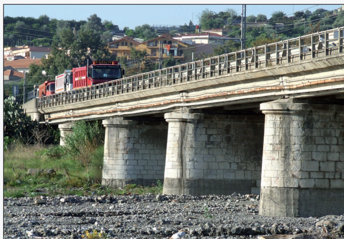
Figure 8A e 8B - Vista di insieme del viadotto D'Agrò e Fiumedinisi
