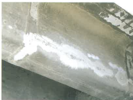
Figura 6 - Particolare dei conci prefabbricati.
