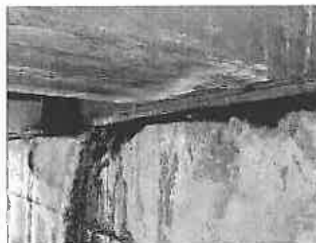
Figura 4. Percolazione di acqua sui pulvini
