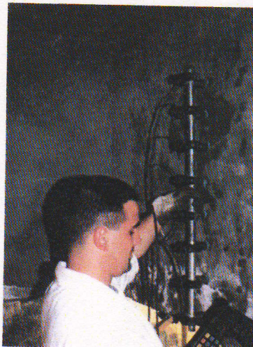
Mappatura del potenziale di corrosione (Uni 9535) sulla s. p. 38, in provincia di Caltanissetta
