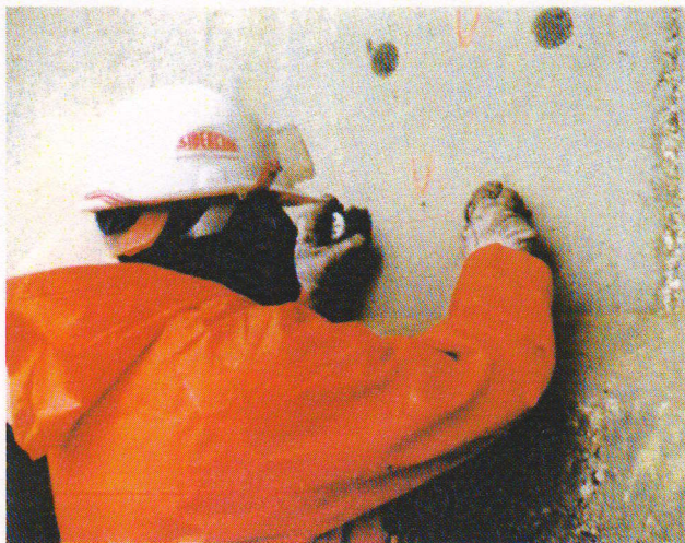
Intervento di diagnosi strutturale sulla s. s. 624 "svincolo di Gulfa". Esecuzione dei rilievi microsismici (Uni 9524)
