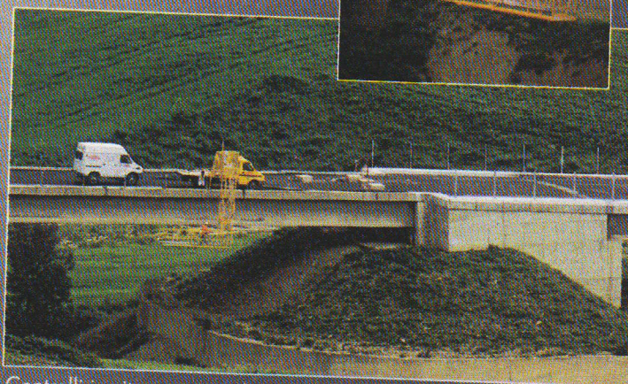
Controlli in situ su ponti: diagnosi e sorveglianza
