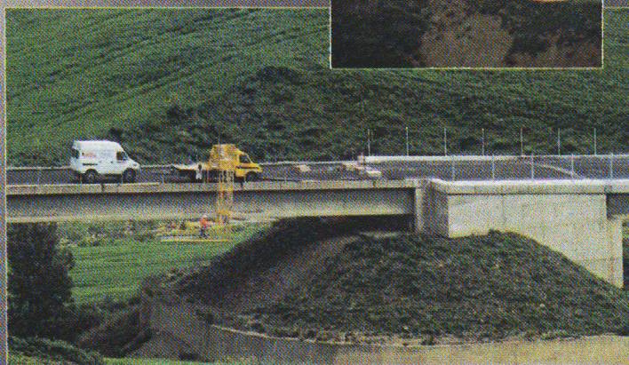
Controlli in situ su ponti: diagnosi e sorveglianza
